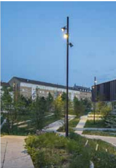
På plassen. Eksempel multimast med flere armaturer
