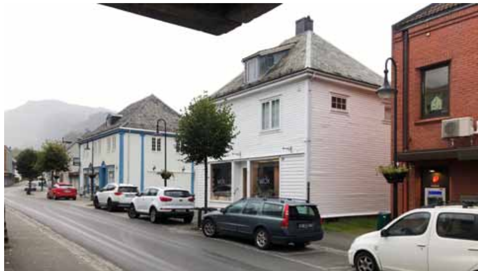
Den gamle trehusbebyggelsen langs Rådhusgata
