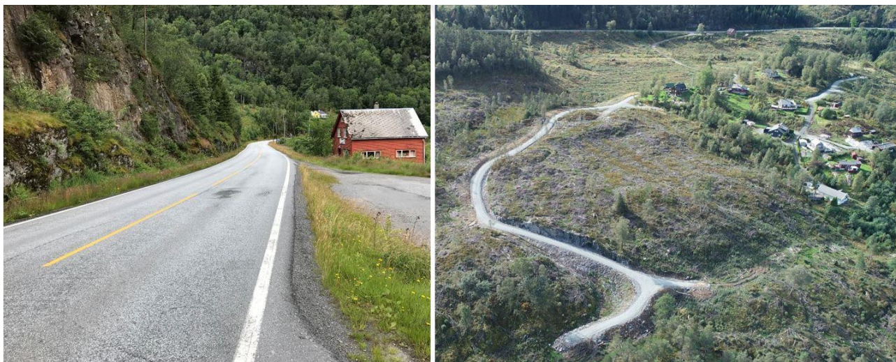
Figur 9 T.v.: Fv. 520 Saudavegen sett frå kryss mot vest. Foto: Norconsult AS. T.h.: Skråfoto av den nye interne veggen til venstre og eksisterande hyttefelt til høgre. I bakkant ligg Fv. 520. Foto: Varicon AS.
