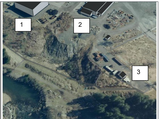
Figur 72 Kommunens bygg for sorteringsanlegg (1), lager/drift (2) og brannøvingfelt (3), Kilde: www.3d.kommuneortofoto.com
