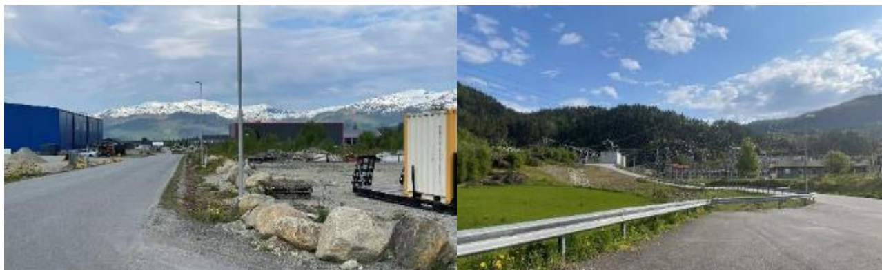
Figur 166: Næringsområdet på Birkelandsmoen, venstre. Sauda transformatorstasjon drives av Statnett og ligger på motsatt side av elven for næringsområdet, høyre.
