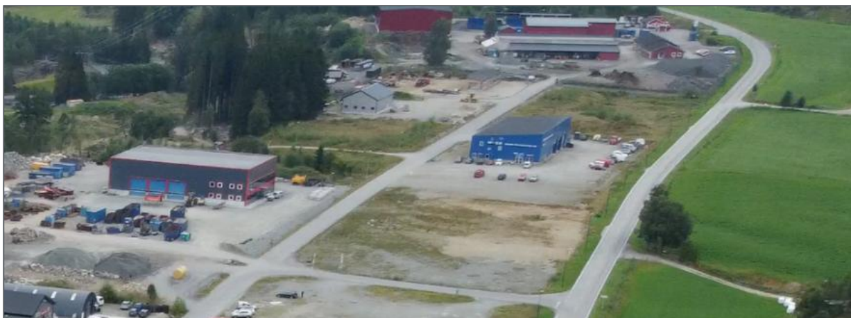
Figur 67 Dagens bebyggelse i øst; bygget til venstre (Aartun) flyttes, grått bygg skal flyttes og blått skal videreføres, Norconsult AS
