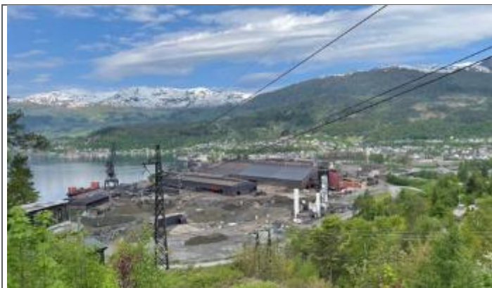
Figur 19 Sauda smelteverket i forgrunnen og sentrum med bebyggelse mot Saudasjøen i bakgrunnen, Kilde: Norconsult AS, august 2023
