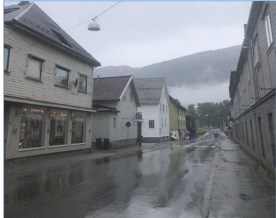
Flere steder smelter kantsteinen sammen med veien eller finnes ikke.
