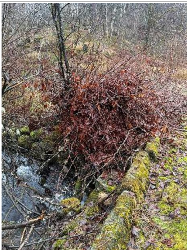
6-1: Mye kvist og annet ved innløpet. Stor fare for tilstopningsproblematikk.
