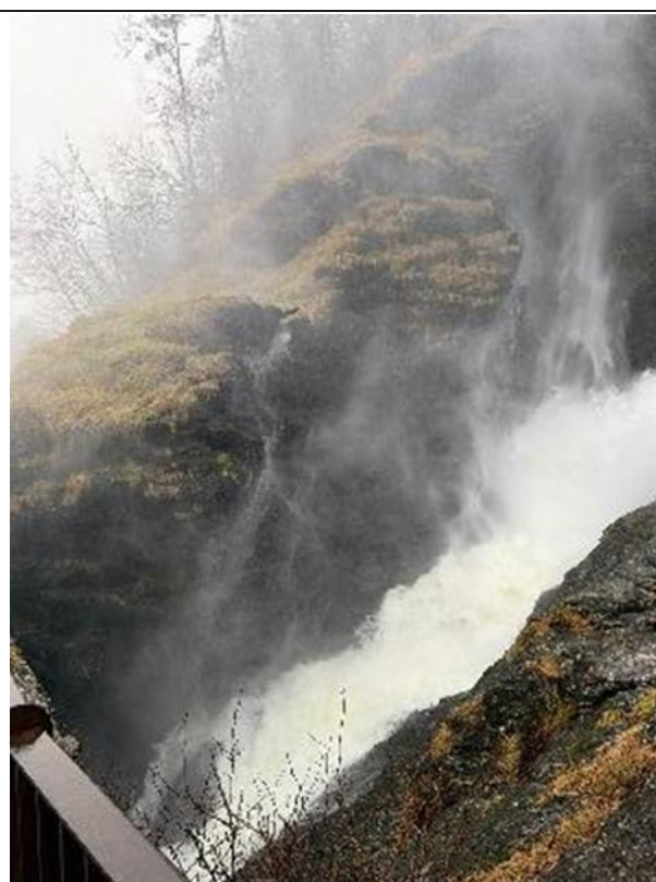
7-7: Vannstrømmen går rett inn i fjellveggen som gir store mengder vann i veien ved ekstremnedbør.
