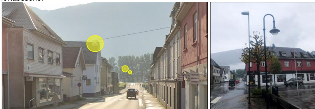
Figur 19: (t.v.) Eksisterende linjeoppheng for belysning. Figur 20: (t.h.) Ulike løsninger for belysning.
