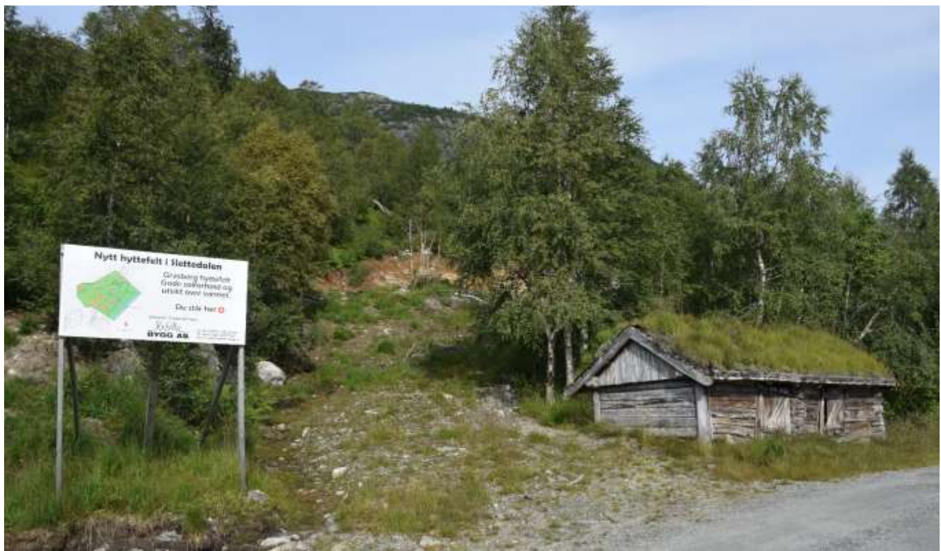
Stølsbua i Slettedalen, som kulturminnenemnda tok vare på, og som Ryfylkemuseet held ved like,, har fått ei vegfylling til nytt hyttefelt tett inn til laftekonstruksjonen. Det er greitt annonsert på skilt ved sida av kven som trugar kulturminnet.
