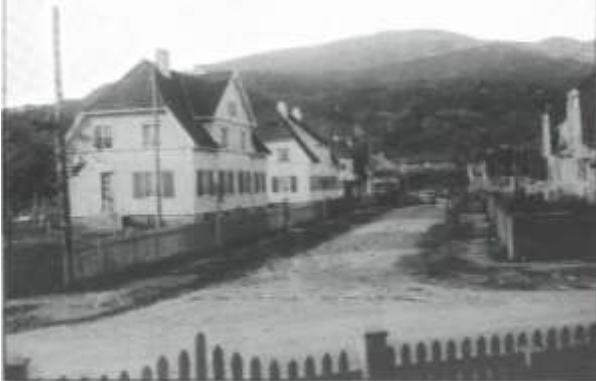
Under arbeidet med å verne Åbøbyen fekk Bruks- og verneplanutvalet utarbeidd i rettleiing om utbetring av bustadhus.
