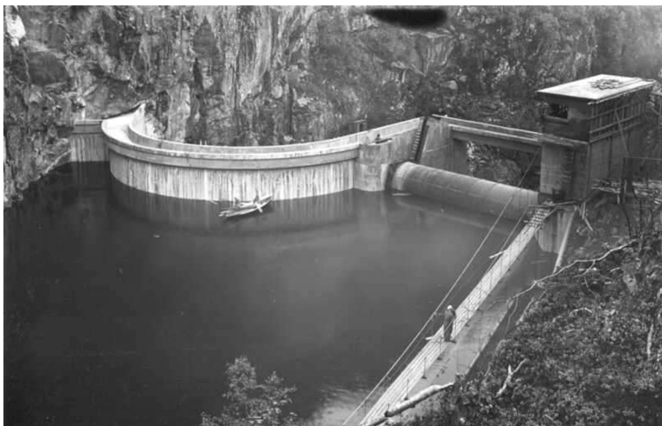
Dam Storlivatn var den første kvelv-, eller buedammen i landet. Han er dessutan kjenneteikna ved ein 15 m brei valseluke, som vi ser til høgre på bildet. Lukehuset er teikna av dei same arkitektane som teikna Stasjon III. Vi har vald eit bilde frå 1930.
