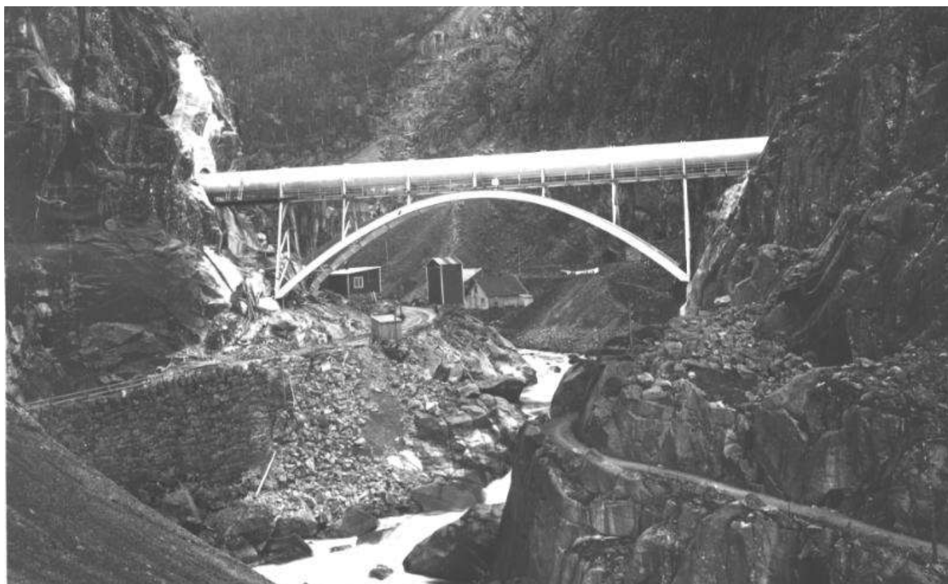
Rørbuen i Tverrdalen er både eit overraskande element og eit byggverk å beundre når ein kjører fylkesvegen til Hellandsbygd. Gruvevegen til sinkgruvene på sørsida av elva. Bildet er frå 1930.
