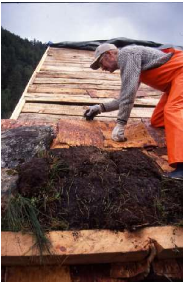
Never og torv var eit billeg og mye brukt materiale til takteking. Ryfylkemuseet har arbeidd mye med å hente fram att kunnskap om den gamle taktekkingsmåten. Brørne Leif Magne og Bjarne Østebø var karar som kunne kunsten.
