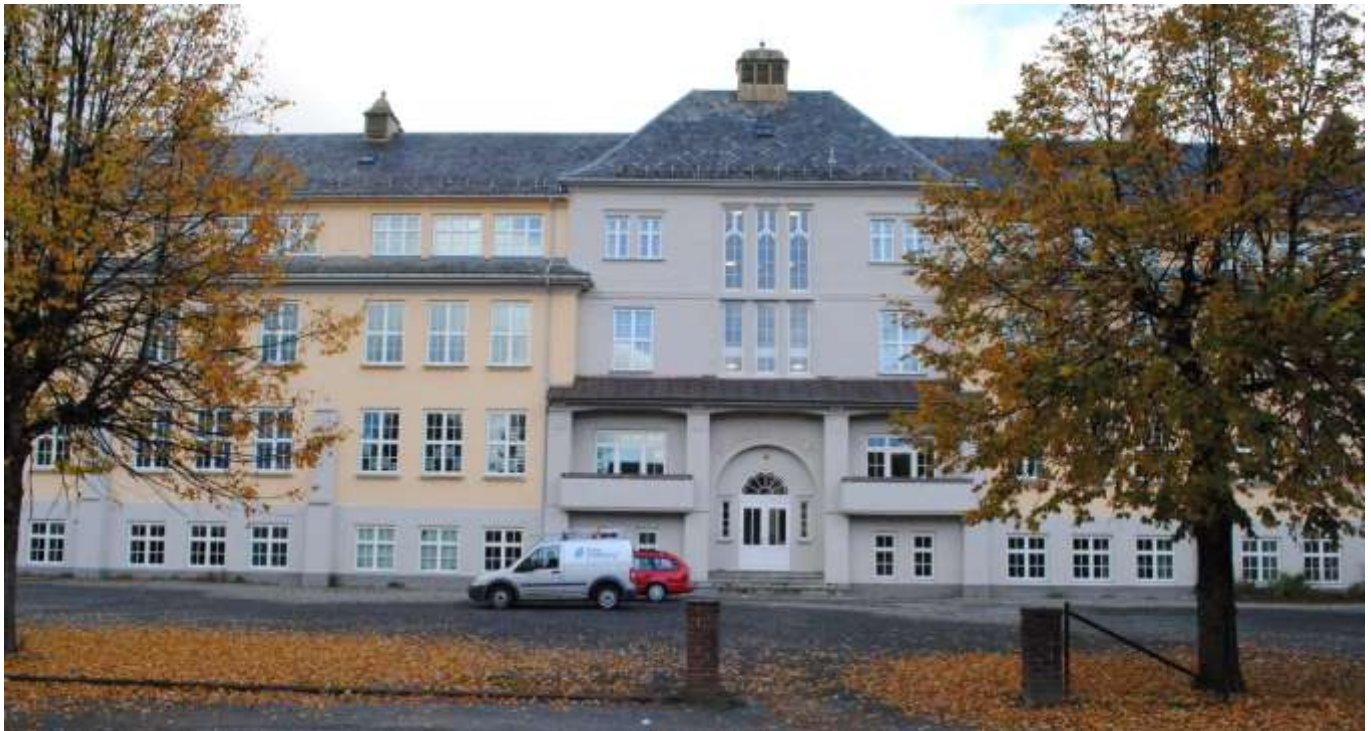
Fløgstad skule blei teikna av Torgeir Alvsaker. Første byggetrinn sto ferdig i 1926. Dei siste åra har skulen gjennomgått ei førebiletleg rehabilitering.
