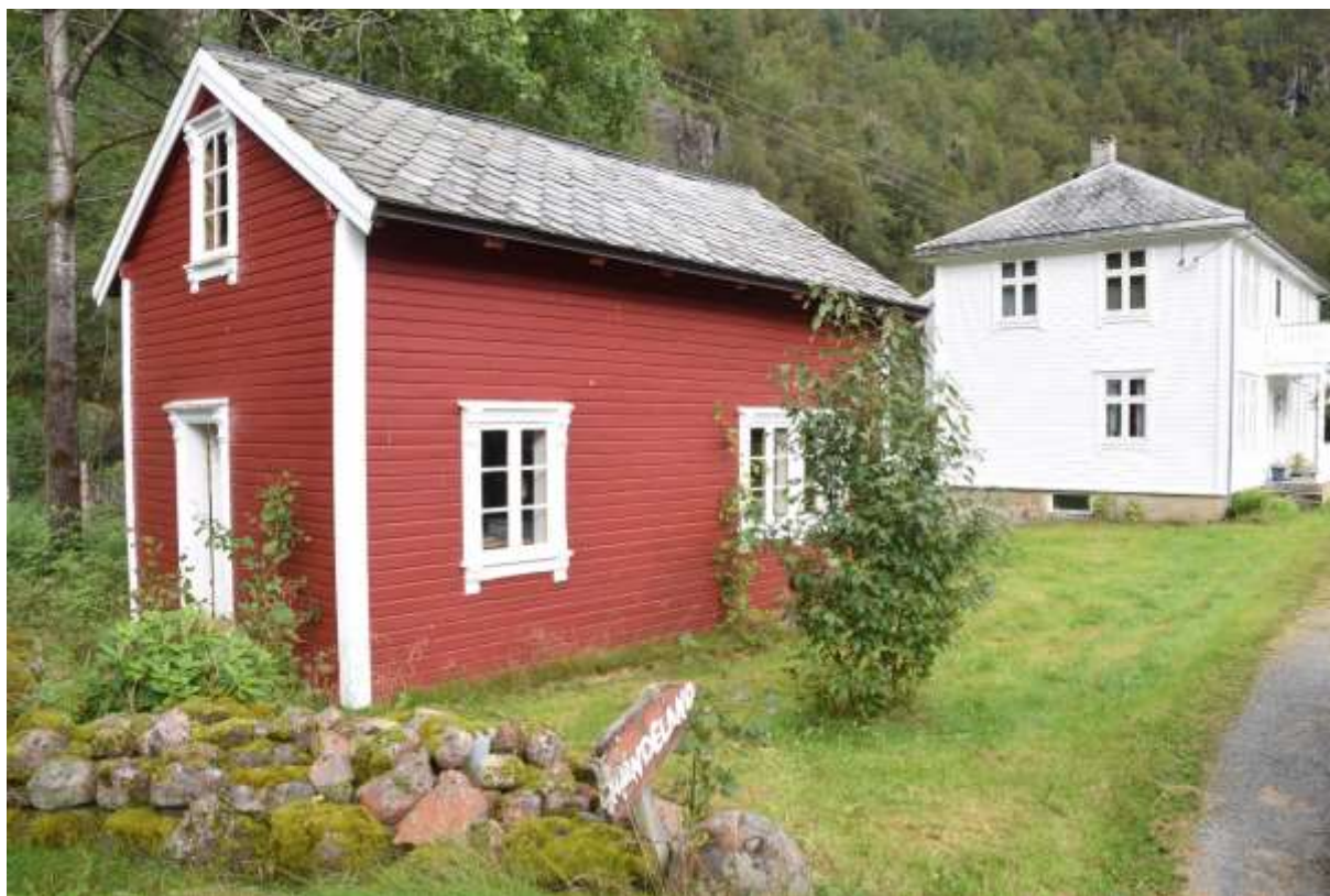
Folgehuset på Handeland, registrert som drenkstove i SEFRAK, er tidfesta til tidleg 1800-tal. Hovudbygningen på garden, som vi ser bak, blei bygt opp att etter ein brann under krigen.
