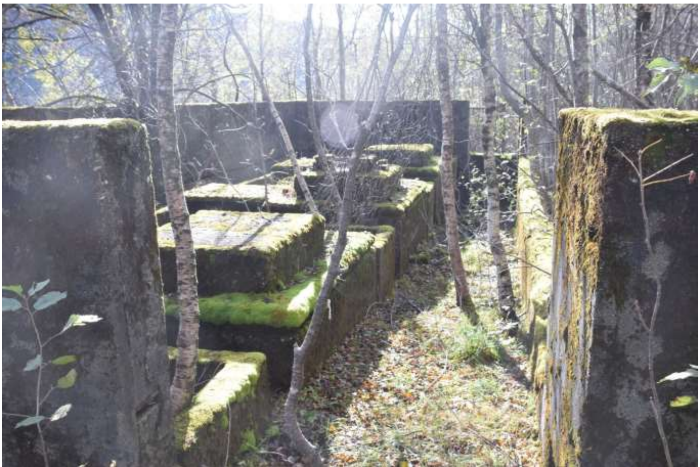
Fundament for transformatorstasjon på Øverland.
