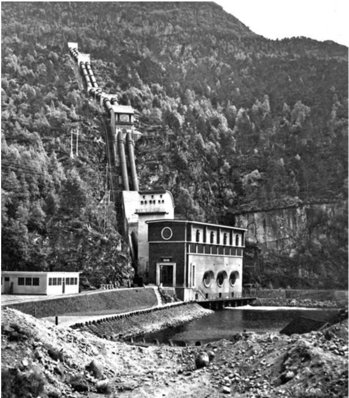
Stasjon III fotografert på 1930-talet. Den mørke stasjonen med det lyse tårnet og rørgata bak utgjør ein heilskap.
