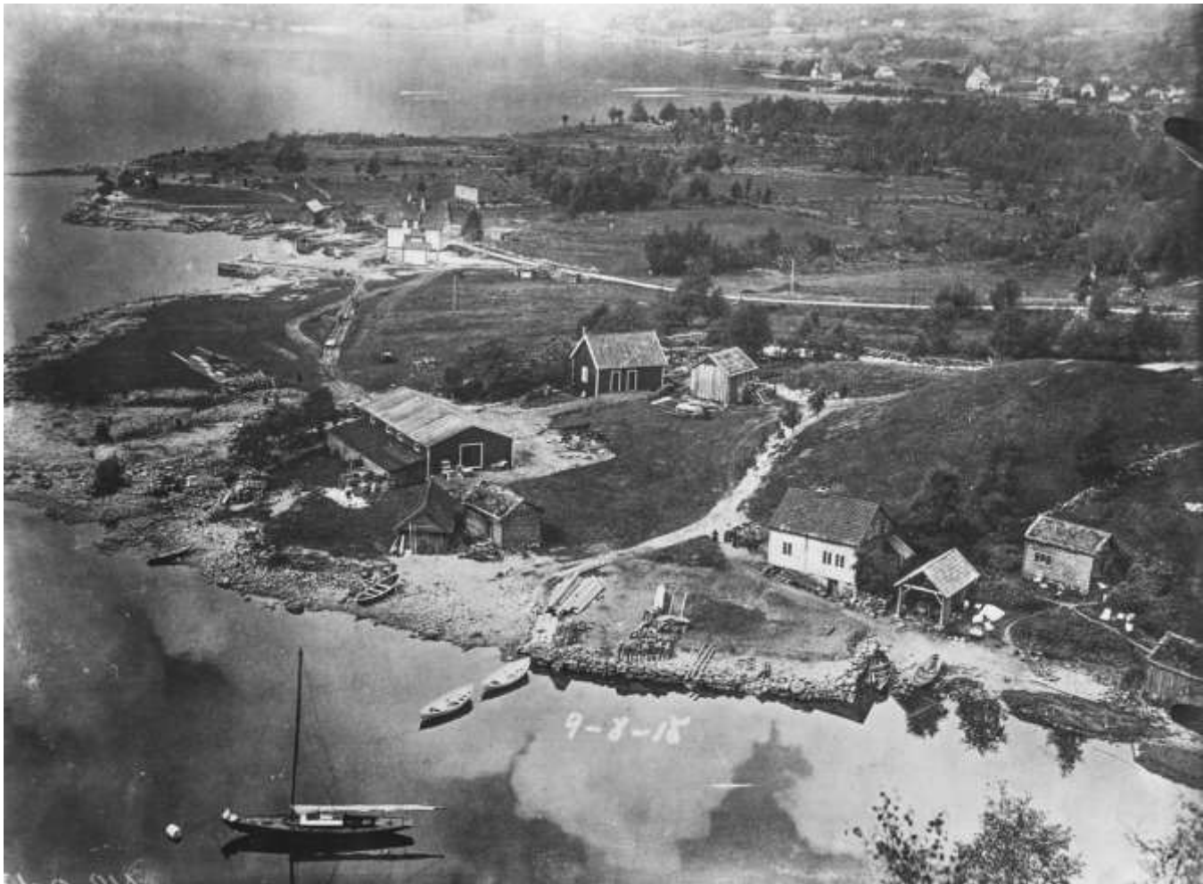
Klubben i august 1915. Delar av den opphavlege busetnaden er framleis intakt, men førebuingane til reising av fabrikkannlegget har starta. Det er m.a. lagt ein skinnegang frå eit lita brygge og fram til eit lagerskur midt i bildet. Bildet skal vera tatt av John Oxaal som var med frå starten og som var verksdirektør frå 1923 til han blei arrestert av tyskarane i 1941.
