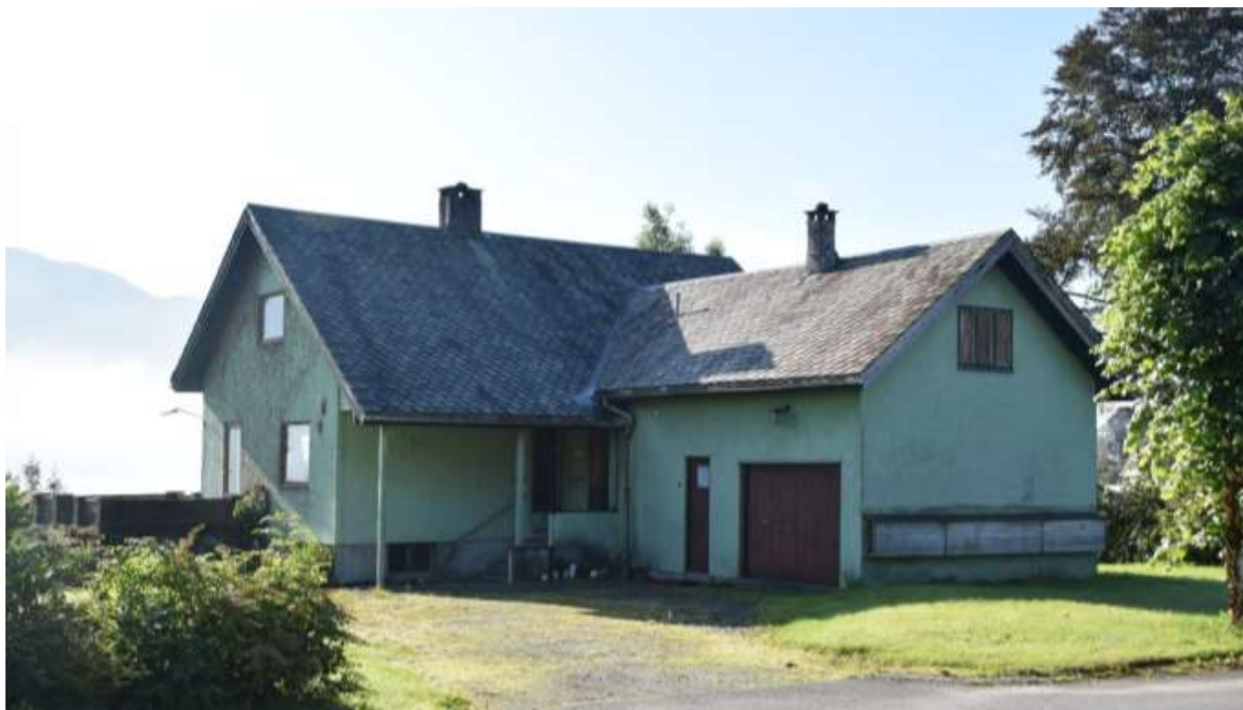
Saua 46 var det første huset som blei sett opp i det nye bustadområdet på Saua gard. Huset er teikna av arkitekt Gustav Helland som elles har sett sterkt preg på Sauda.
