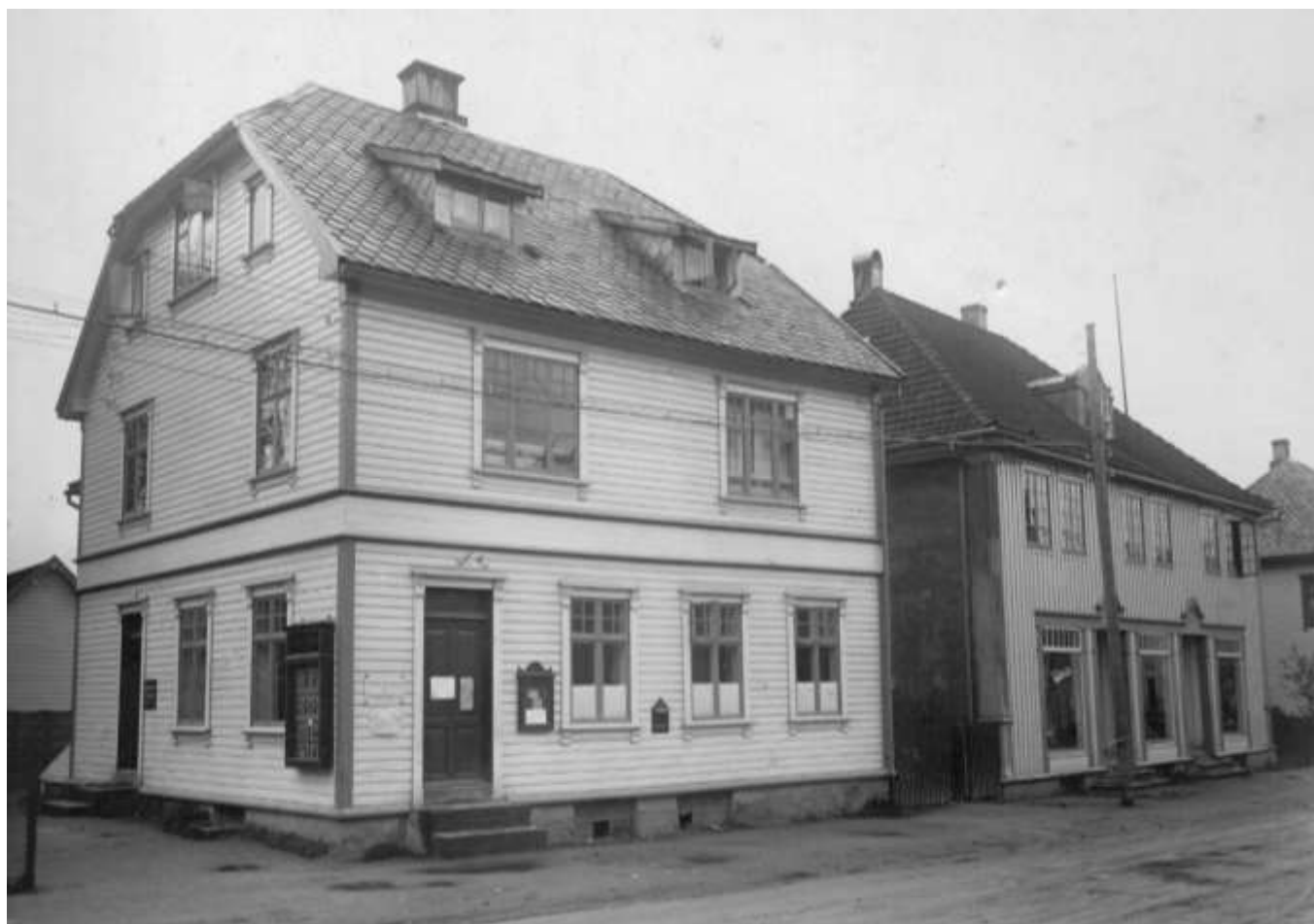
Rådhusgata 27 og 29 kan stå som døme på dei opphavlege kvalitetane med bygningsmiljøet på Øyra. Bygningane har trekk av jugendstil og nyklassisisme. Mye av detaljeringa på nr. 27 er framleis i behald. Nr. 29, nærmast, brann i 2016, og reiser utfordringane med tilpassing av nybygg til den gamle arkitekturen. Bildet er lagt ut på «Gamle Sauda» av Nils Olav Eidhammer.
