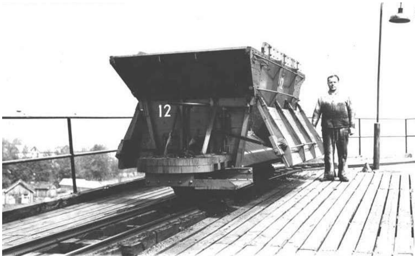
Kabelbanen var ei innretning som saman med dei gamle smelteomnane er dei delane av smelteverket som mange snakkar om når dei skal forklare dei store endringane i teknologien. Ivrige vernarar av historia til smelteverket har lukkast med å ta vare på ei av vognene. Foto lagt ut av Jan-Georg Solland på Facebook-sida "Gamle Sauda».
