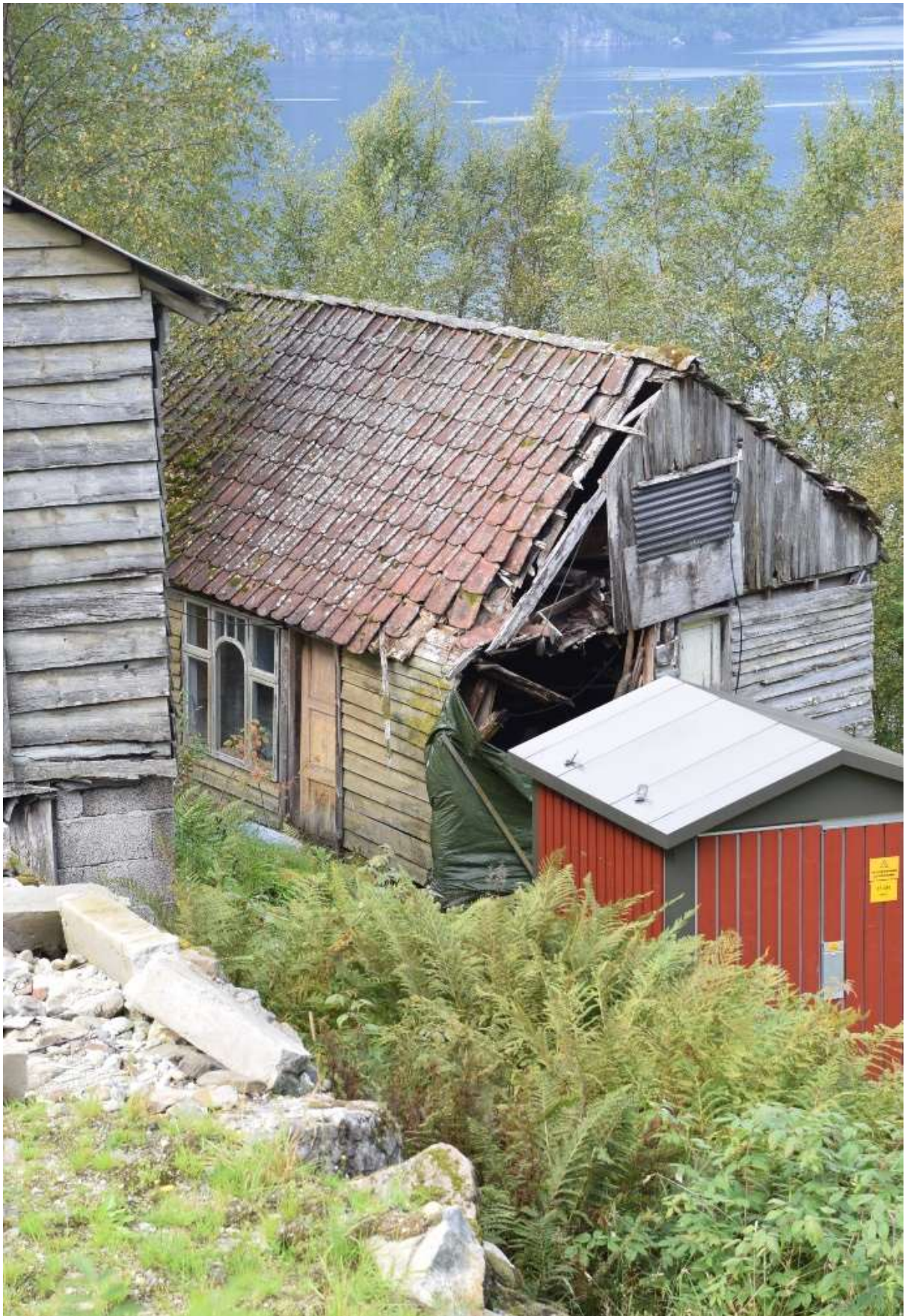
Klimaet fører raskt til forfall når bygningar ikkje lenger blir haldne ved like. Her er det i tillegg plassert ein ny trafostasjon midt i kulturminnet.
