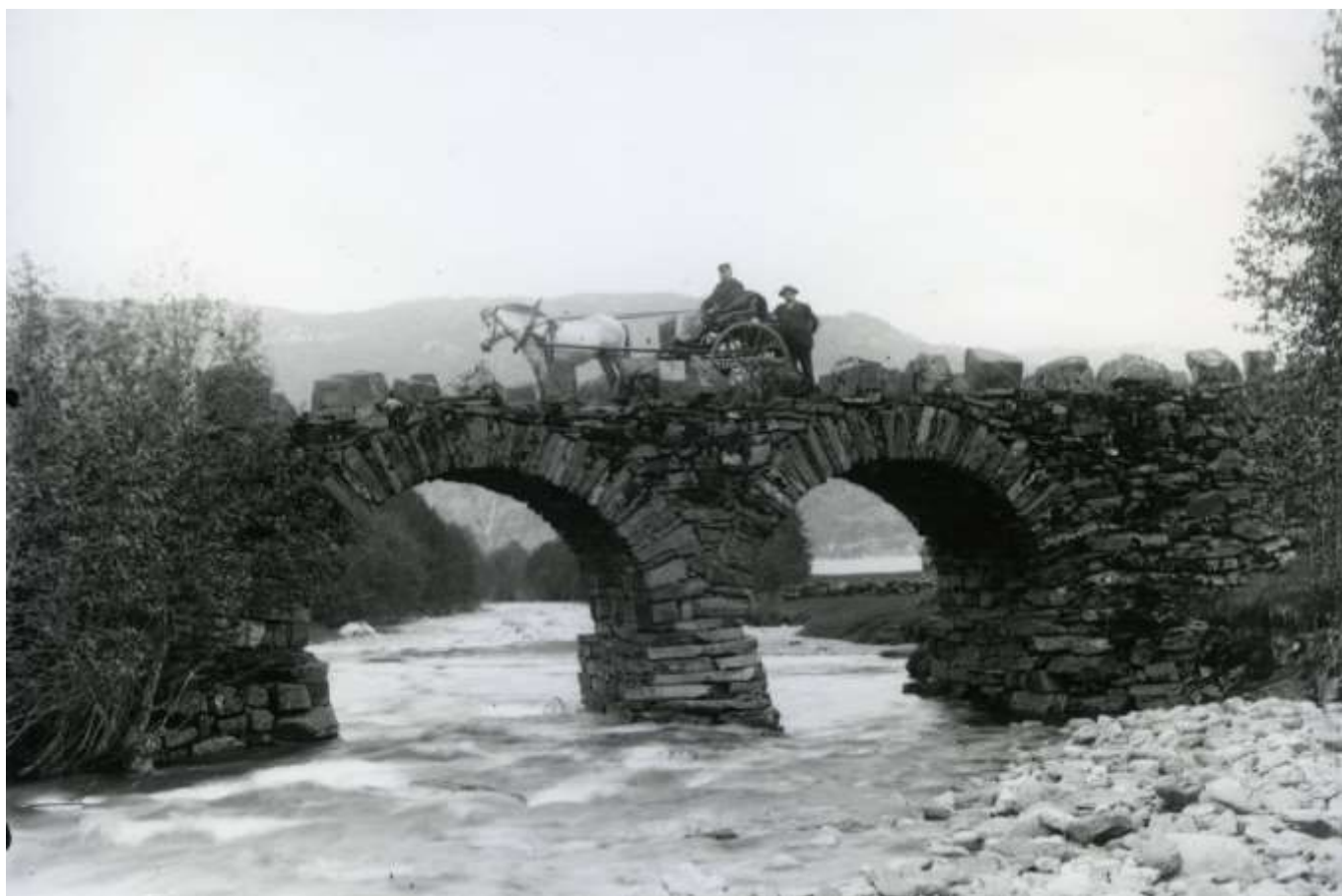
Nes Bru i Saudasjøen, her fotografert i 1901, var ferdig i 1873, 13 år etter at den same byggmeisteren, Lars Henrik Qualheim hadde bygt Høllandsbrua i Indrebygda. Foto: Rogaland vegkontor/Statsarkivet i Stavanger.
