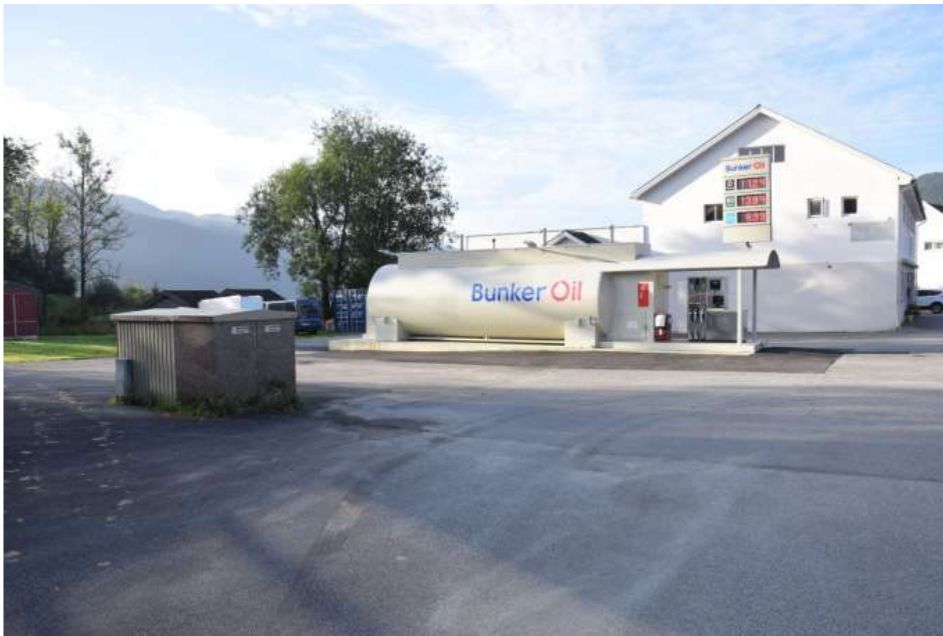
Drivstofftank, trafostasjonar og konteinarar forsøplar bygningsmiljøet i Saudasjøen.
