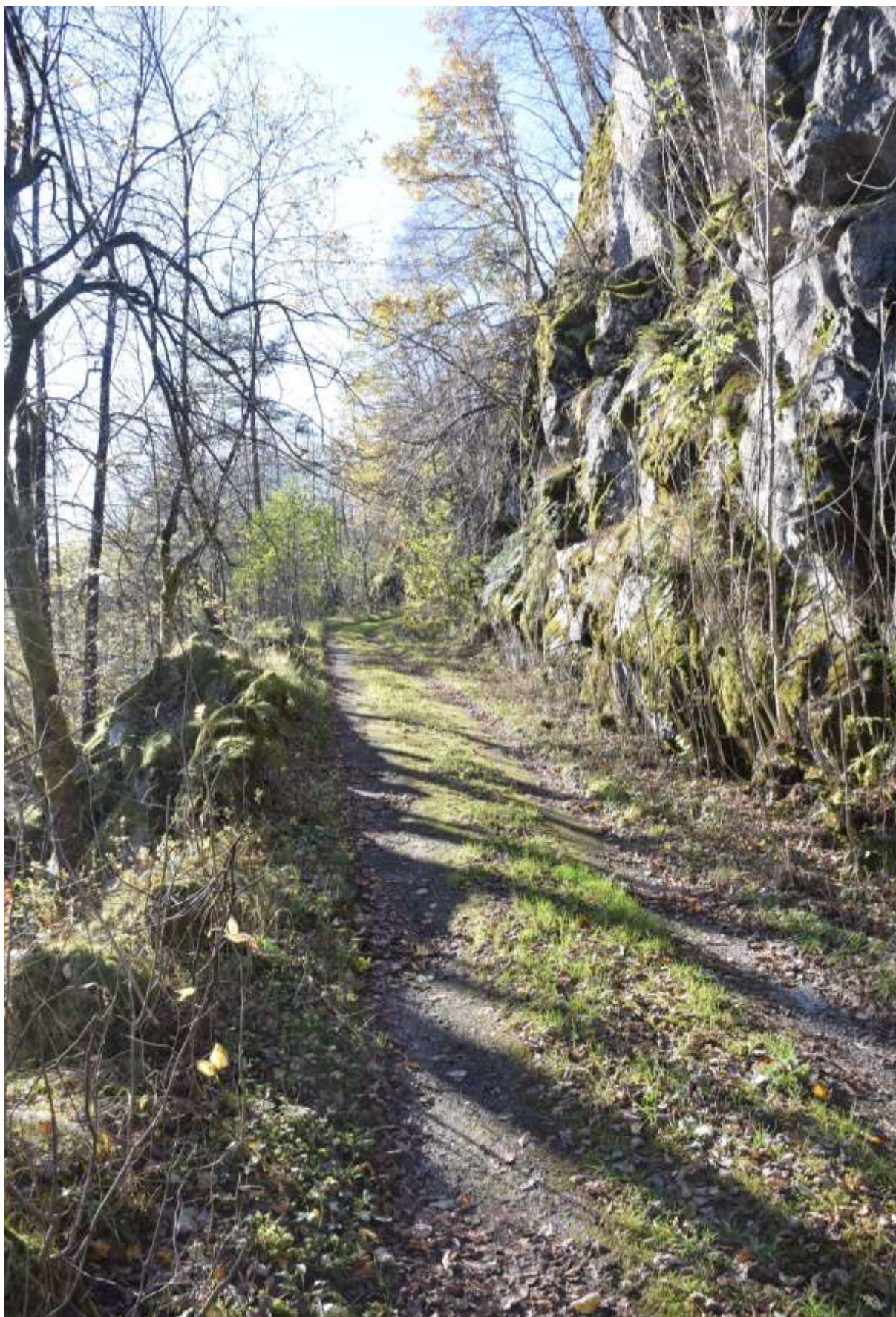
Gammel strekning av Dollarvegen nedom Hustveit. Innskrift i fjellveggen viser at denne delen av vegen blei bygt i 1924.
