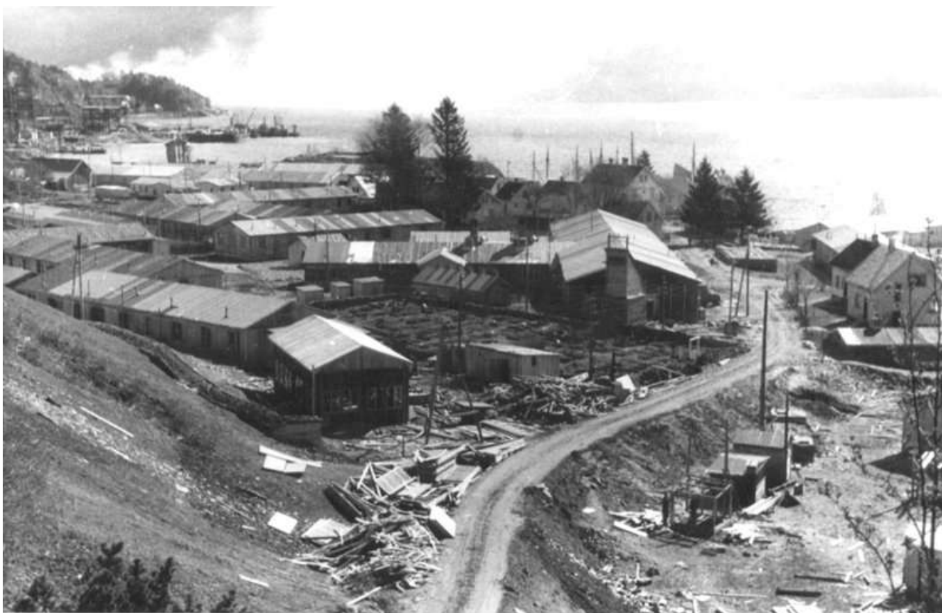
Planane til A/S Nordag om å bygge ein aluminiumsoksidfabrikk kom til å omforme heile Saudasjøen til ein brakkeby som på det meste måtte huse 2 700 arbeidrarar. Foto: Nordag.
