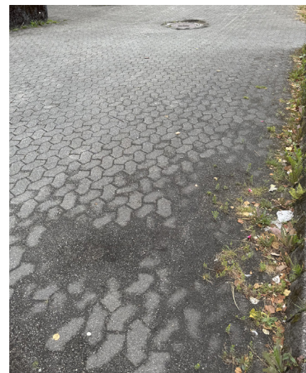
Figur 68: Eksisterende dekke i byrommet.
