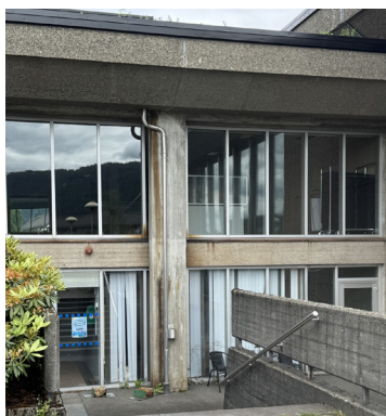
Figur 36: Store glassflater og betongkonstruksjon ved inngangen til hallen.
