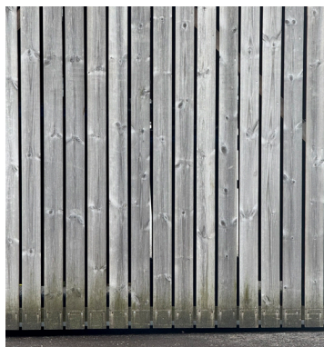
Figur 35: Kledningen på skuret.
