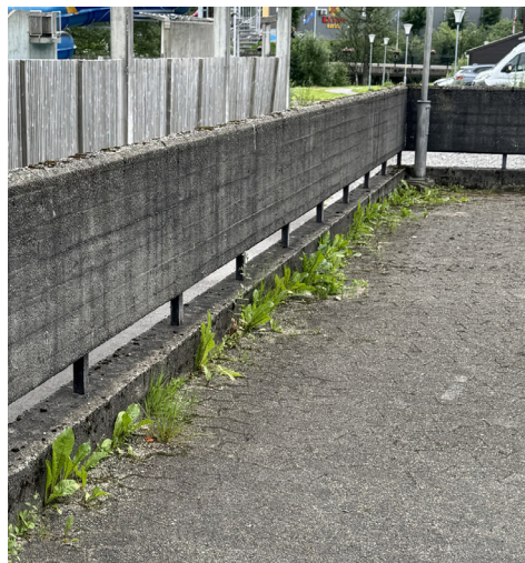
Figur 64: Eksisterende rekkverk langs byrommet.
