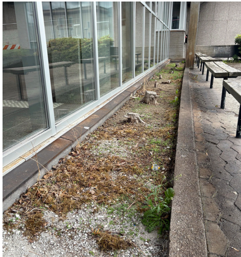
Figur 44: Eksisterende situasjon i bedet langs fasaden.
