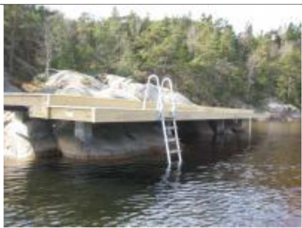
Figur 37: Eksempel på brygge forankra i berg, mogleg ved BBS1, Kjelde: Skjærgårdsbrygger.no
