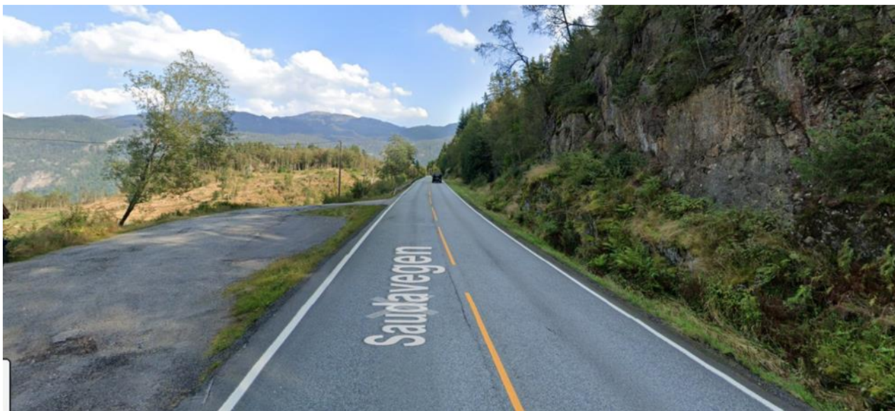
Figur 8: Strekninga kor avkøyrsla skal flyttast vestover (nærmare fotografens ståstad), Kjelde: Googlestreetview
