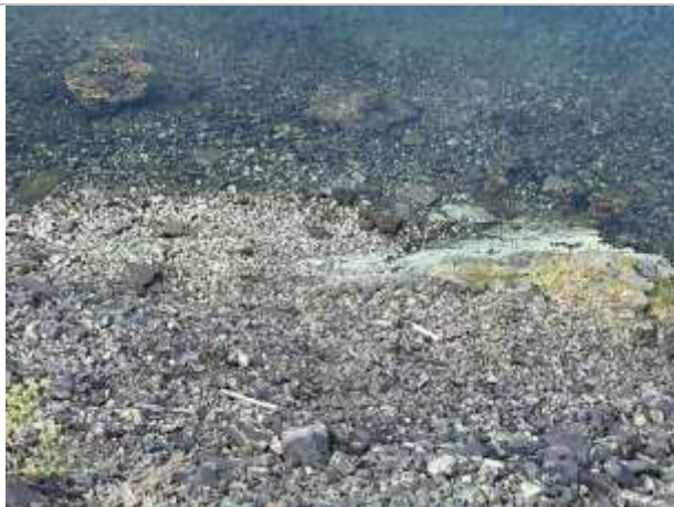
Figur 37 Indre del av Sønnåhavn, tidligere fylte masser/slakkstoffer, overgang fylling/sjø, Foto: Norconsult AS, 5.5.2022
