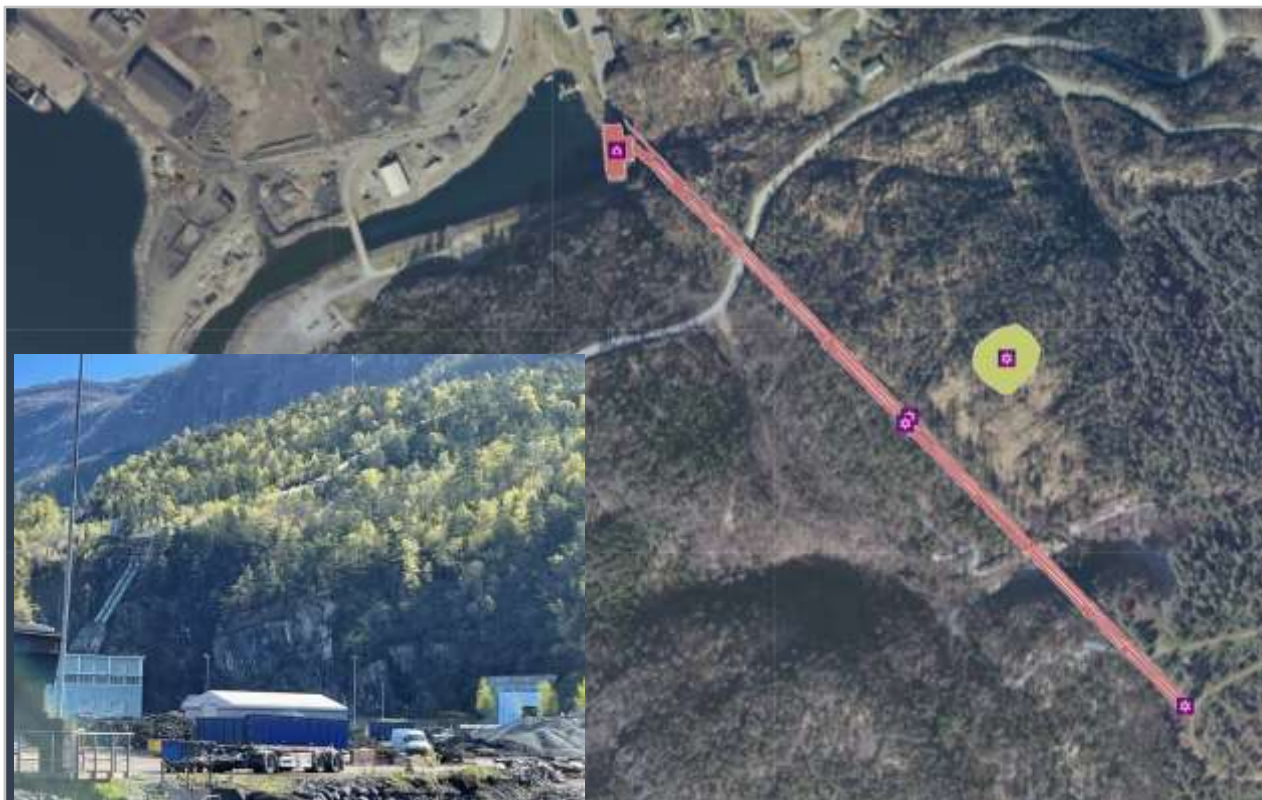
Figur 28 Forskriftsfredet kraftverk Sauda III, fra 1920/1930-tallet, rørgaten inngår i fredningen; foto (innfelt) er tatt fra plassering ved Eramet sin kai; Kilde: kart.naturbase.no/Kulturminnesøk og Norconsult AS.
