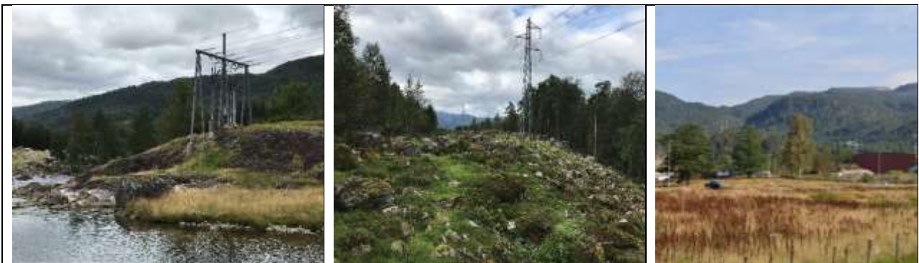
Figur 6 Master til kraftledningen ved Saghølstræet (venstre), ved Birkeland 2/Nord (midten) og øst for Birkeland (kommunens driftstasjon, til høyre). Kilde: Norconsult 2022
