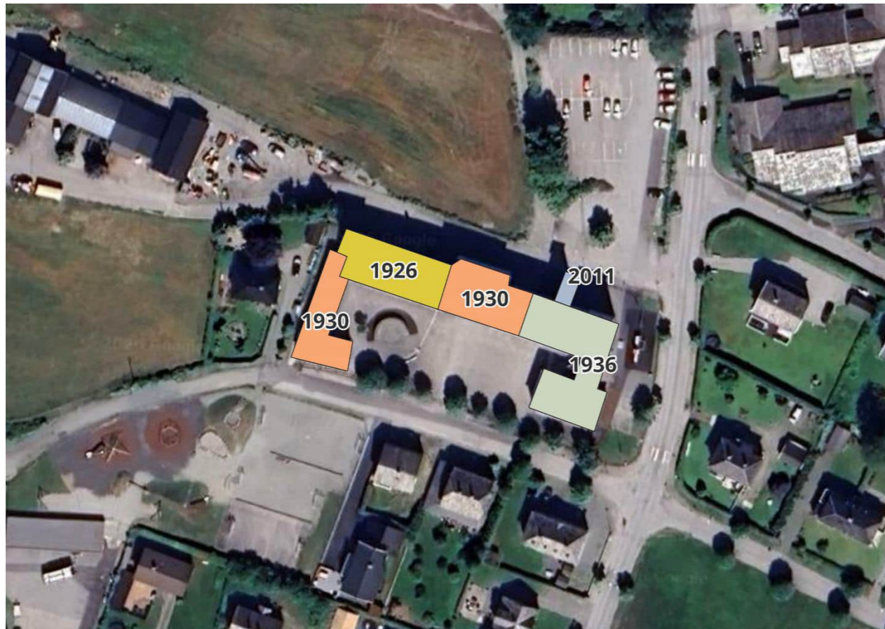
Figur 4 Ortofoto av Fløgstad skule som viser byggetrinn med byggeår.
