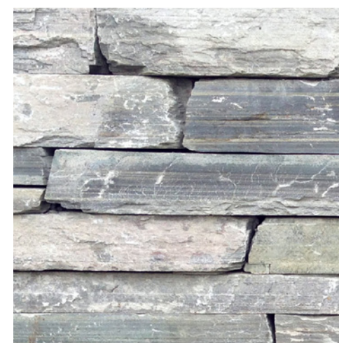
Skiferstein i tørrmur gir et tidløst uttrykk og harmoniserer godt med eksisterende materialbruk
