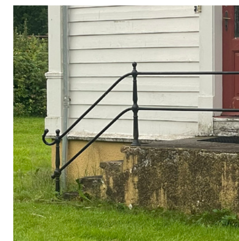
Svartlakkert stål brukt på rekkverk og håndløpere er et gjennomgående element flere steder i Åbøbyen
