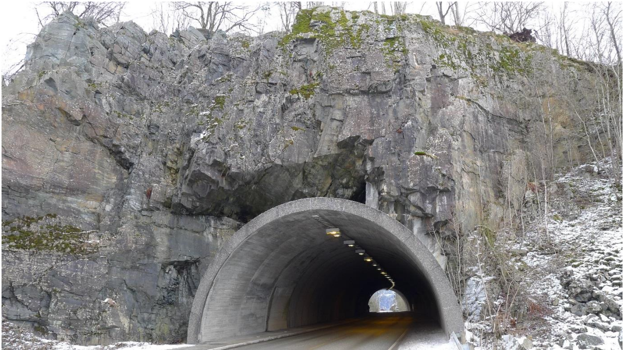
Bilde 2 Forskjæring og påhugg vest.
