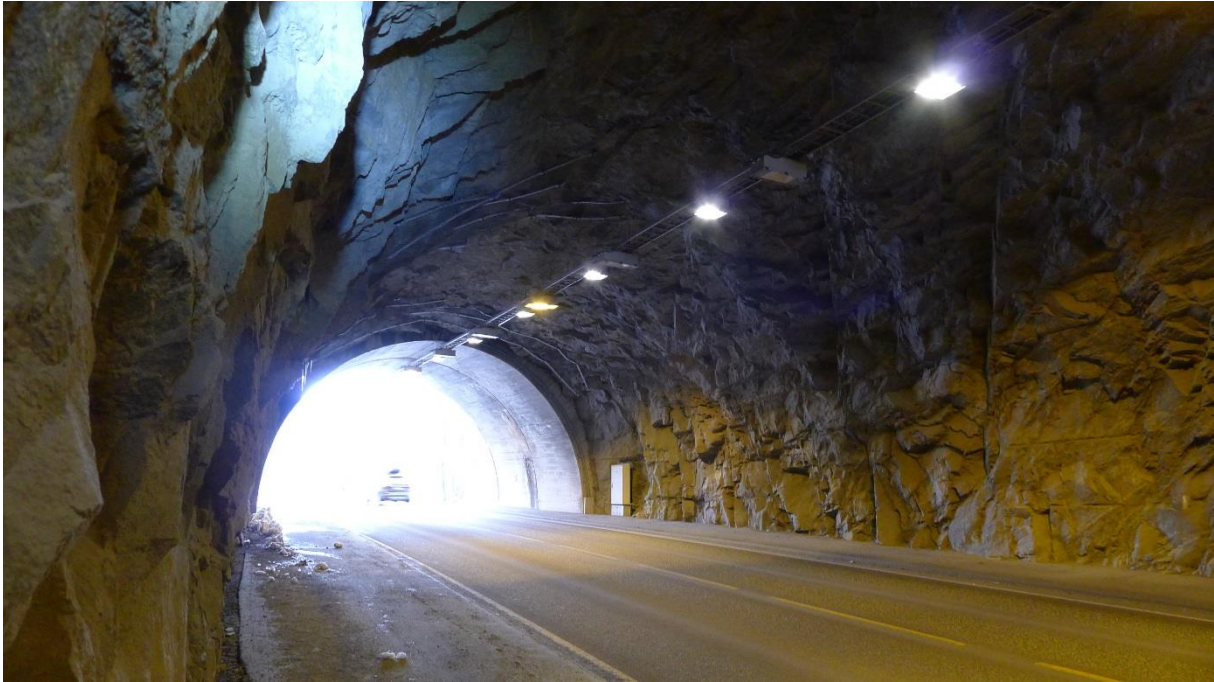
Bilde 6 Bilde av tunnel tatt fra start av hvelv inne i tunnel mot øst.
