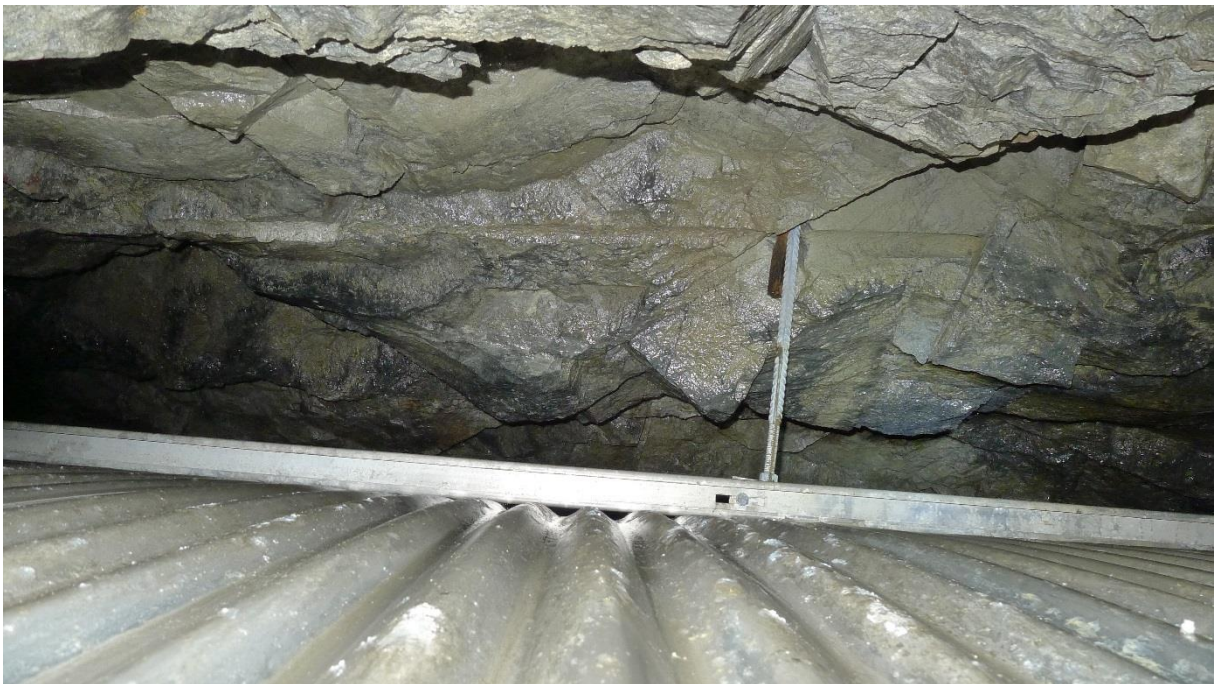
Bilde 9 Bilde tatt fra luke venstre side på baksiden av hvelv opp mot heng.
