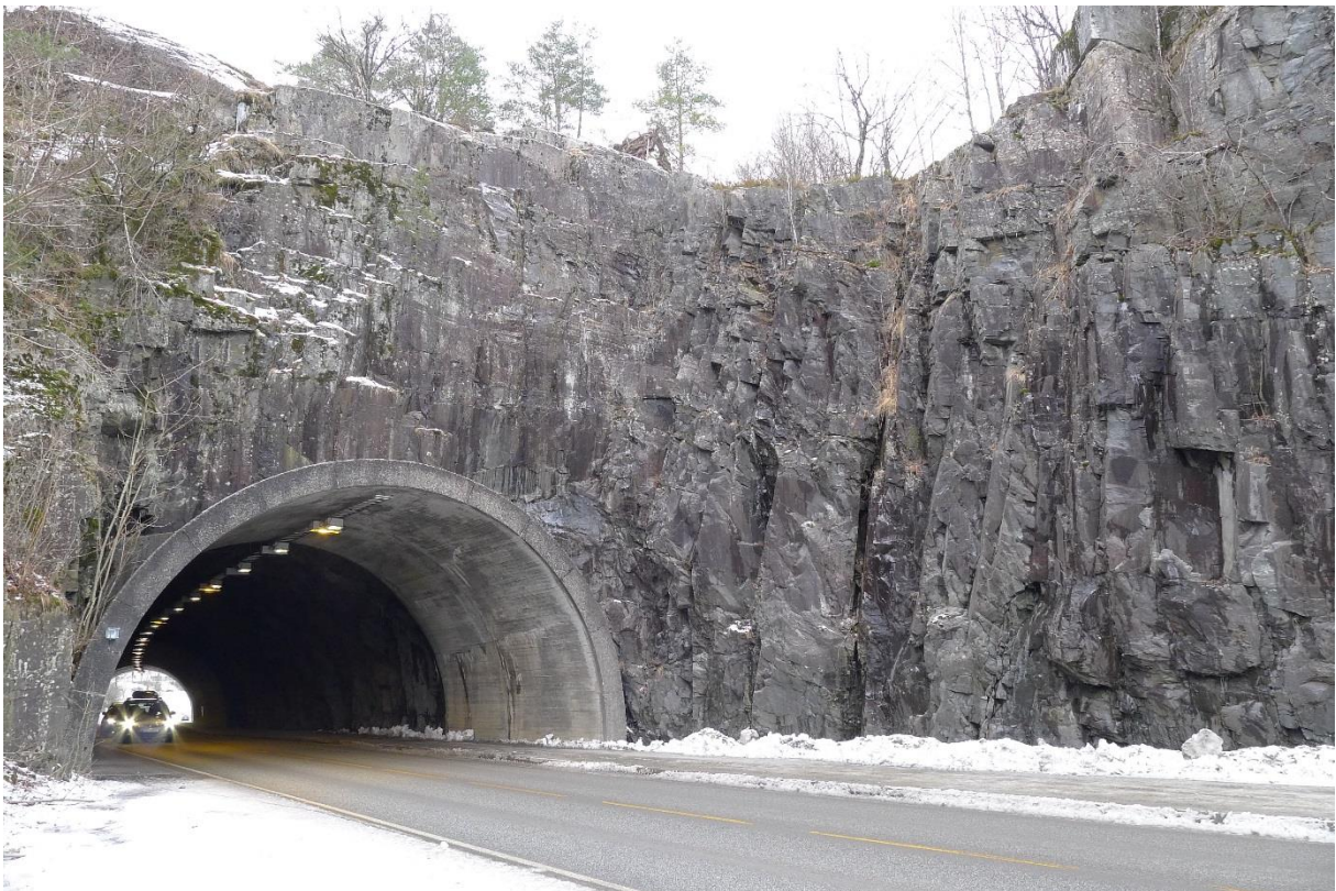
Bilde 3 Forskjæring og påhugg øst, GPS 56.
