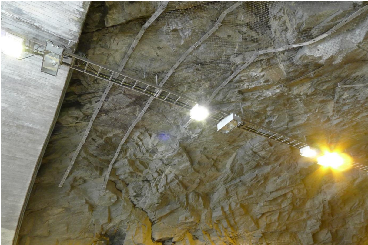
Bilde 5 Bilde av bergsikring rett innenfor østre portalstøp.
